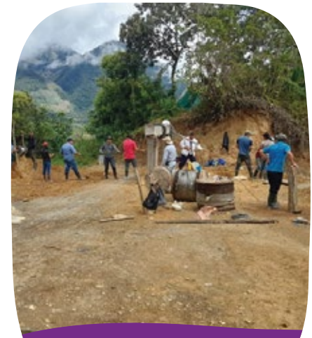
Obra en ejecución
